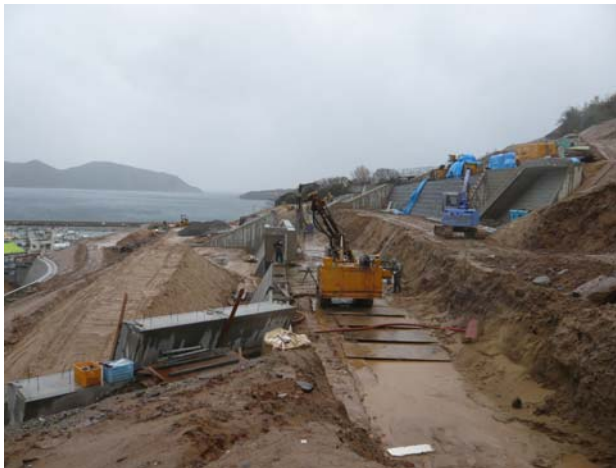
写真1 撤去がおわり造成が進む玄界島(2007)
